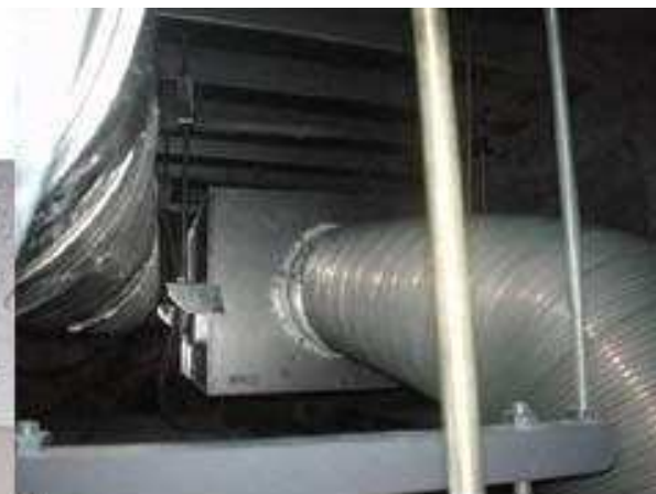
天井裏に排気装置を増設
